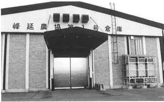
改修で設置したエアコン室外機と断熱構造扉
