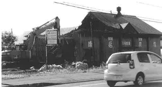
光珠内11号倉庫の取り壊し
