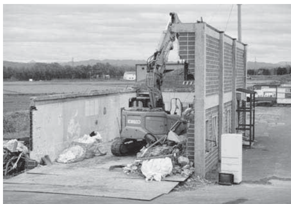
解体中の旧中小屋支所 (10月17日)
