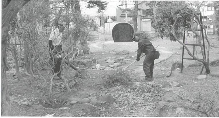
落ち葉や枝を撤去する作業員
